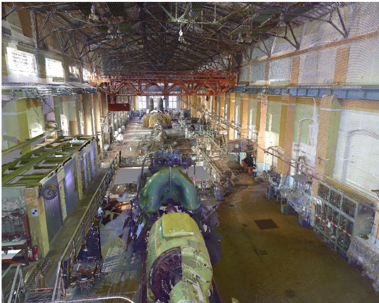
Bild: Stiftung Kraftwerk Hirschfelde, Digitalisierung Kraftwerkshalle durch HTW Dresden
